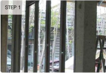
ติดตั้งโครงคร่าวโลหะสำหรับผนังเบา C64 / U66 หรือ โครงคร่าวโลหะ C74, U76 โดยเว้นระยะห่าง 0.60 ม. หรือ 0.40 ม. และปิดด้านหนึ่งด้วยแผ่นสมาร์ทบอร์ด เอสซีจี ด้านหนึ่ง
