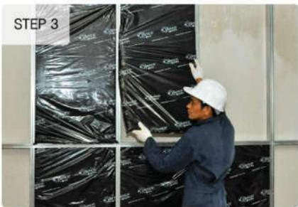
ติดตั้งวัสดุอะคูสติก เอสซีจี สำหรับผนังกันเสียง รุ่น Cylence™ ZoundBlock™ ระหว่างโครงคร่าวให้เต็มช่องว่าง โดยเริ่มจากตรงกลางไปด้านบน หากระยะไม่พอดีสามารถตัดแผ่น Cylence™ ZoundBlock™ โดยใช้คัทเตอร์ และปิดด้วยเทปอลูมิเนียมพอยล์
